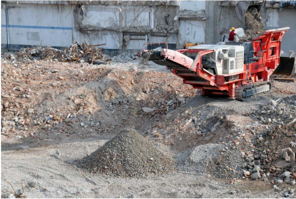
Abbildung 5: Erhöhte technische und organisatorische Anforderungen an die Aufbereitung von festen Gemischen, z.B. von Bauschutt. (© Stihl024/Fotolia)
