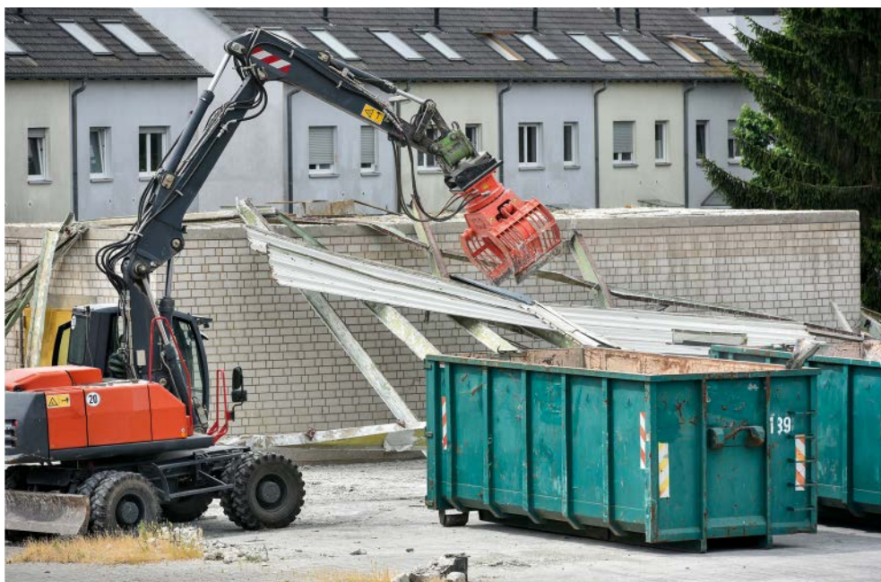
Abbildung 4: Keine erhöhten Anforderungen an die Zwischenlagerung fester Gemische, die bei Bautätigkeiten auf der Baustelle anfallen. (© digital-stack/Fotolia)
