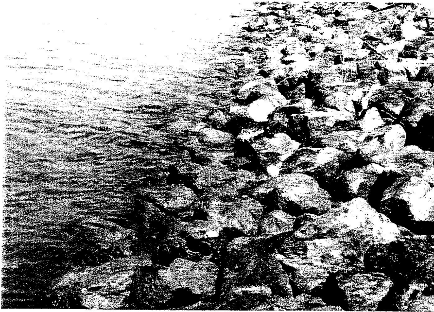
Abb. 5: Uferbefestigung mit Wasserbausteinen
